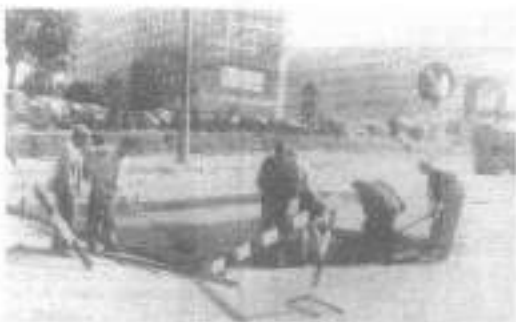
Roboty drogowe wykonywane w ul. Józefa Posańskiego w Jastrzębiu
